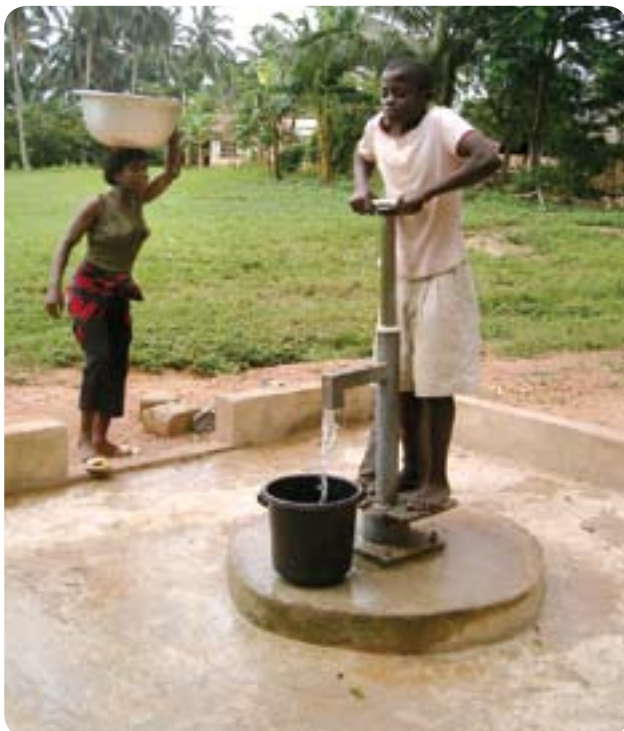
Die Brunnen von Assin müssen dringend gesäubert und saniert, viele Pumpen in stand gesetzt werden.
